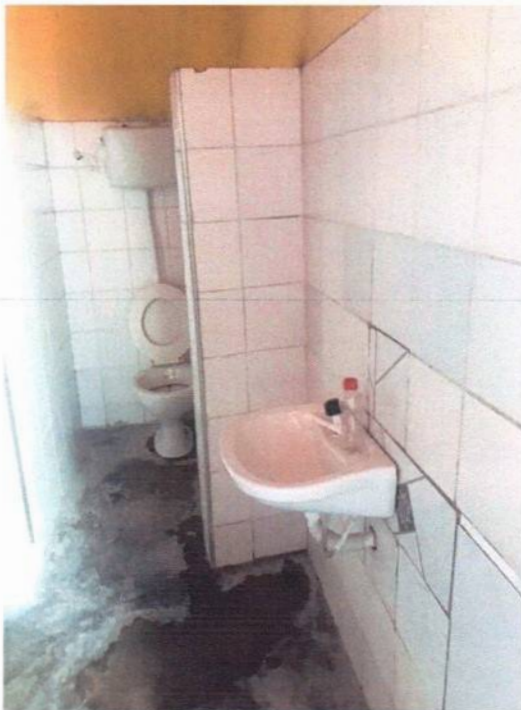
Figura 5: Situação dos banheiros
