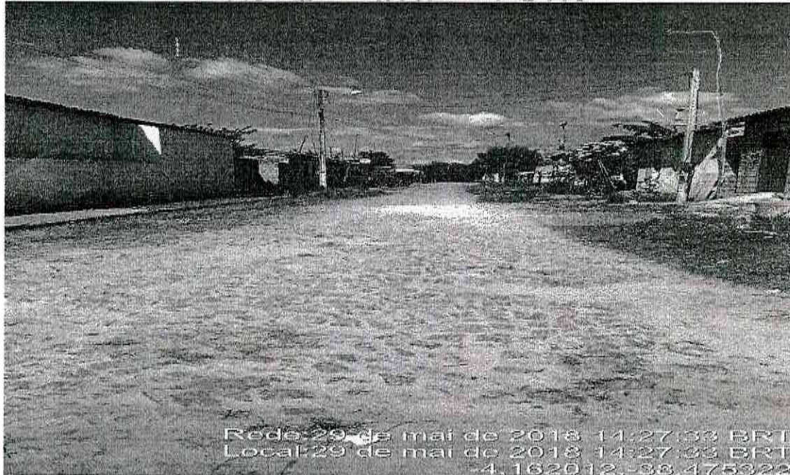
RUA RAIMUNDO SEGUNDO INICIO
